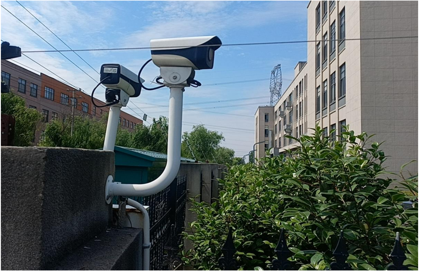
围墙安装监控.jpg
